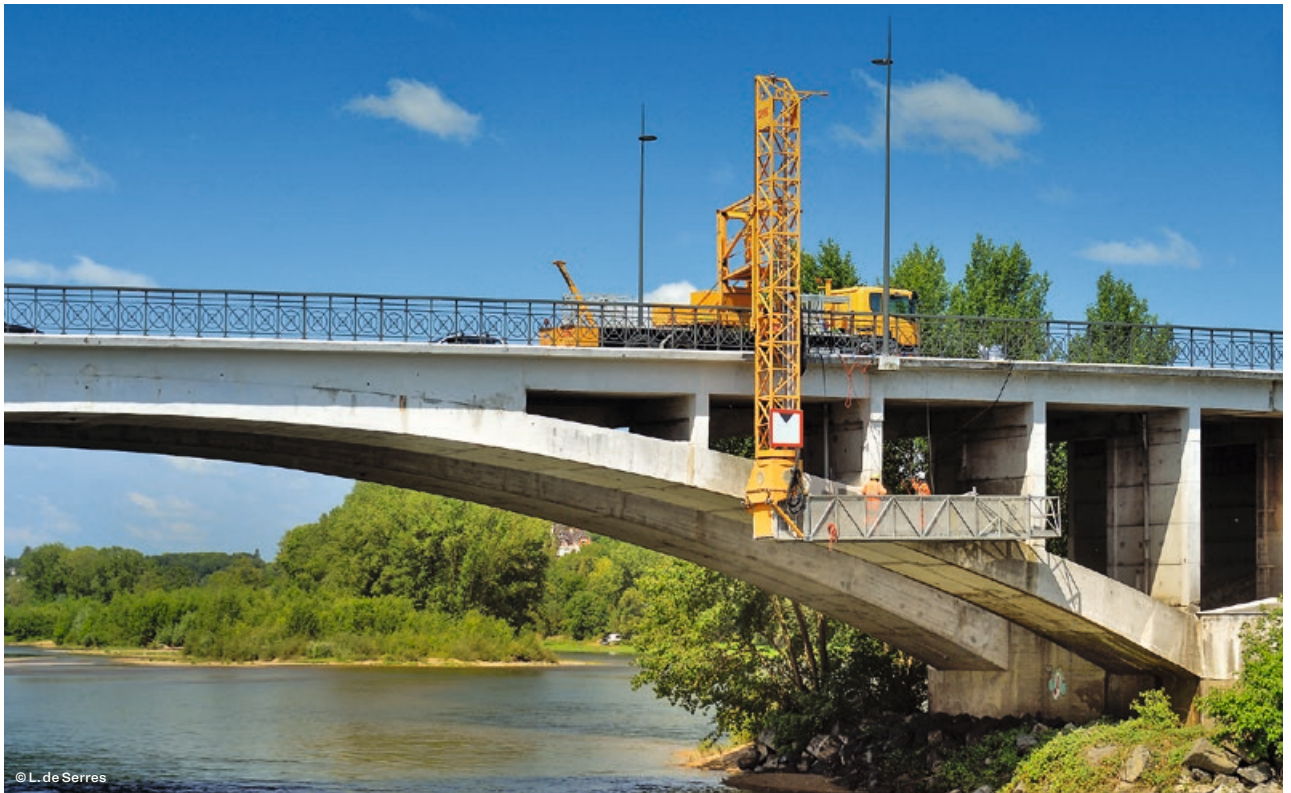
Pont Napoléon : Mise en place d'une nacelle négative afin de vérifier l'ouvrage
