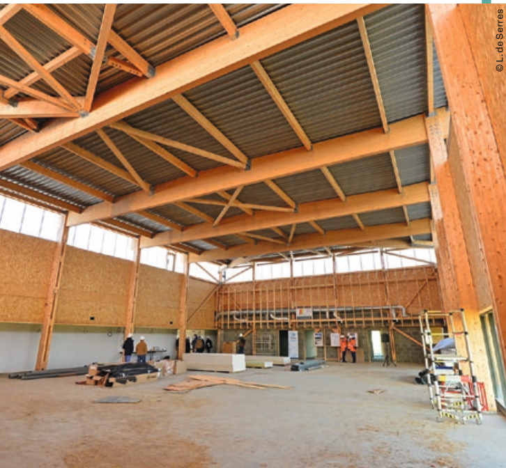
Le chantier de la future salle sportive polyvalente de Druye.
