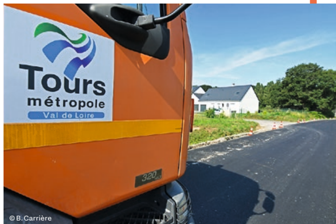
Reprise joints de chaussée rue de Verdun à Joué
