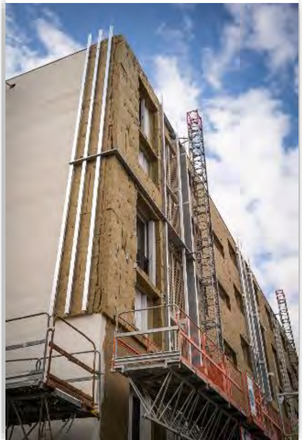
Figure 81 : Chantier de rénovation thermique d'un immeuble rue Saint-Barthélémy, à Tours, en août 2021 (© François Lafitte, Ville de Tours)
