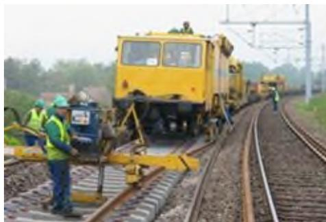
Longs Rails soudés sur traverses béton
