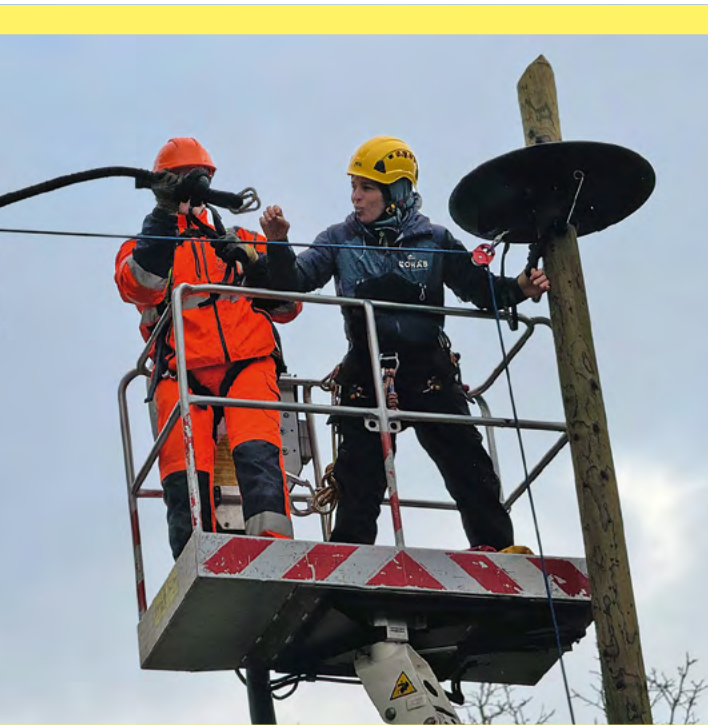
Installation de l'écuroduc à Rochecorbon.
