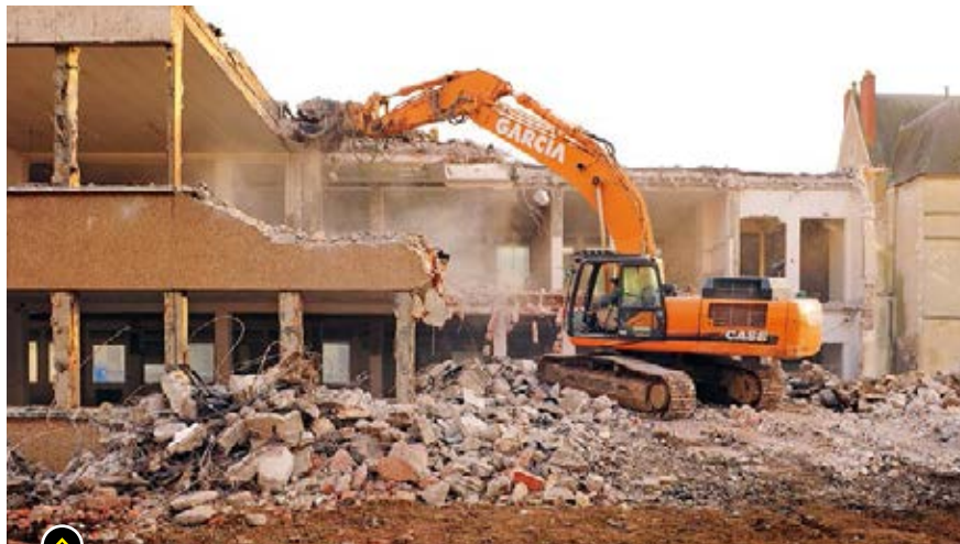
Démolition de l'arrière du bâtiment.
