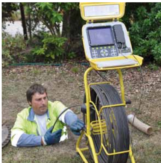
L'inspection vidéo permet de contrôler l'état des réseaux depuis la surface du sol sans creuser de tranchée.
