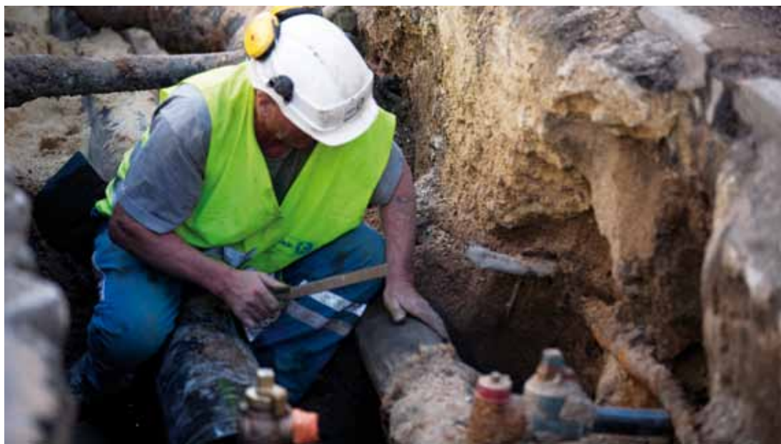
Dévoisement des canalisations au début des travaux du tramway
