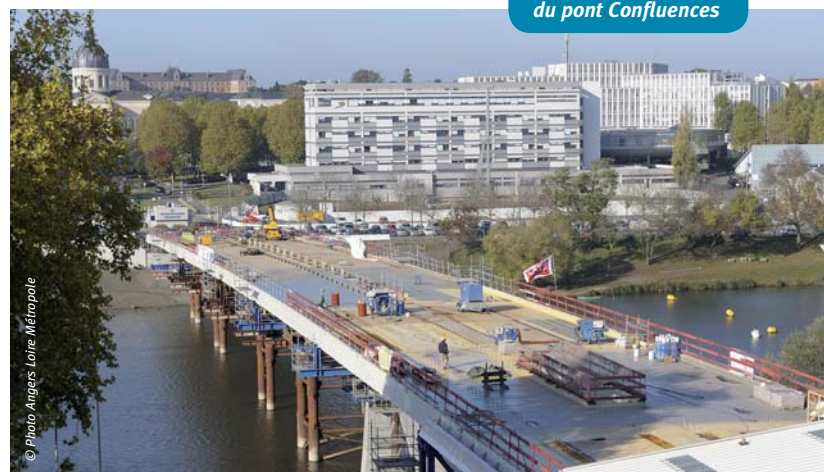
Construction du pont Confluences
