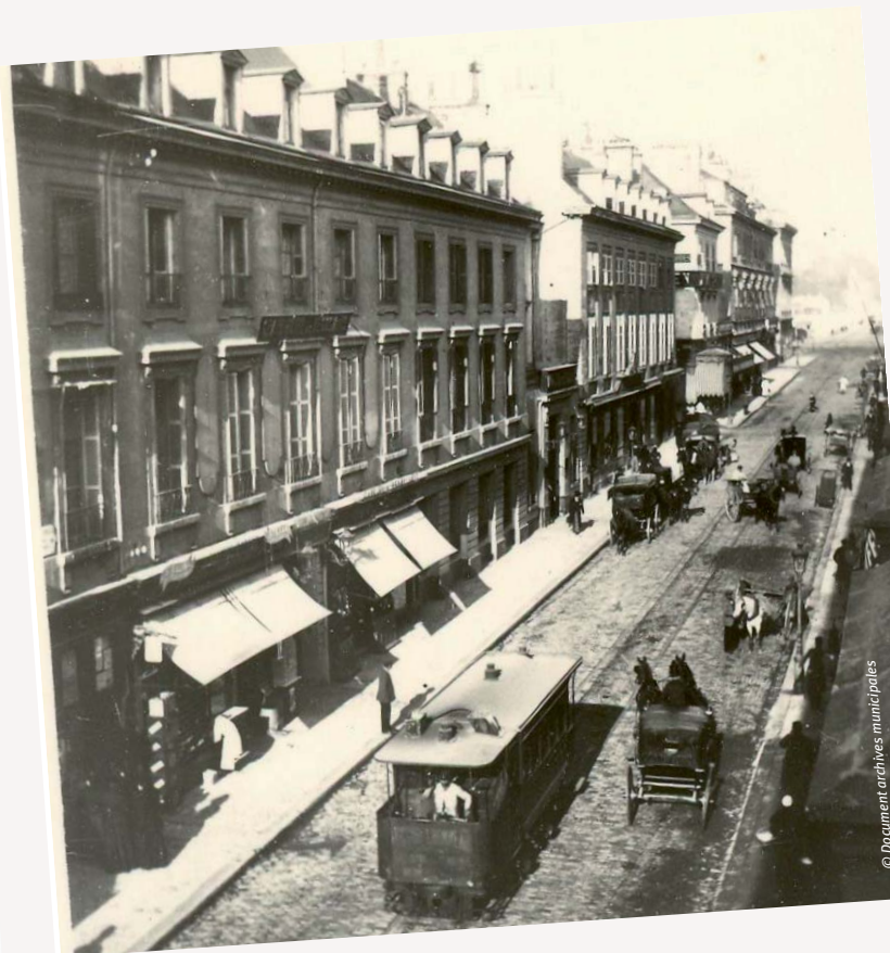
Premier tramway électrique boulevard Heurteloup
