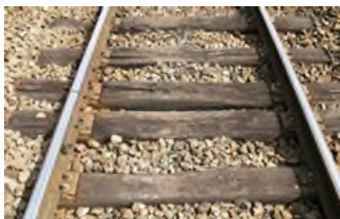
Rails courts sur traverses bois
