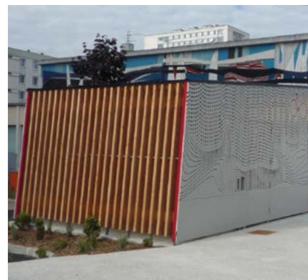
Abris vélos sécurisés mis en place le long de la 1 ère ligne de tramway, réservés aux abonnés Fil Bleu. © Crédits : ATU
