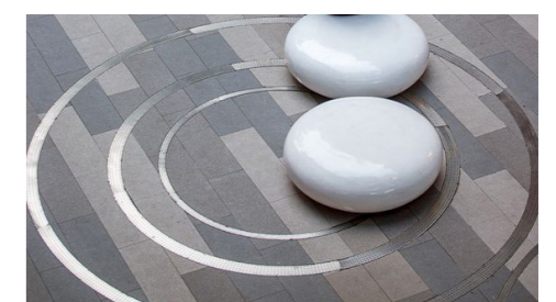
Lisse métallique pour le point de convergence
