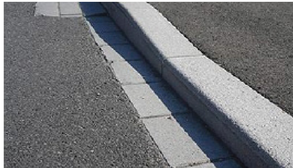
Bordure larg. 20cm Avec ou sans caniveaux selon la pente disponible En rive de voirie
