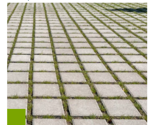
Pavés béton pour les stationnements
