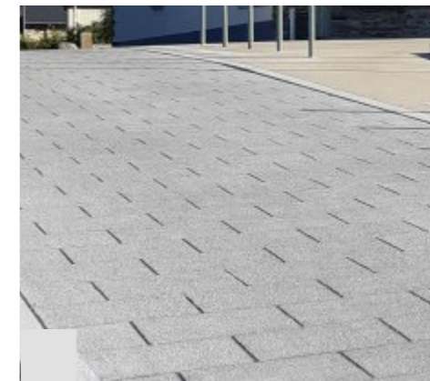
Résine roxem (empreinte pavés 30x60) pour le plateau du PEM
