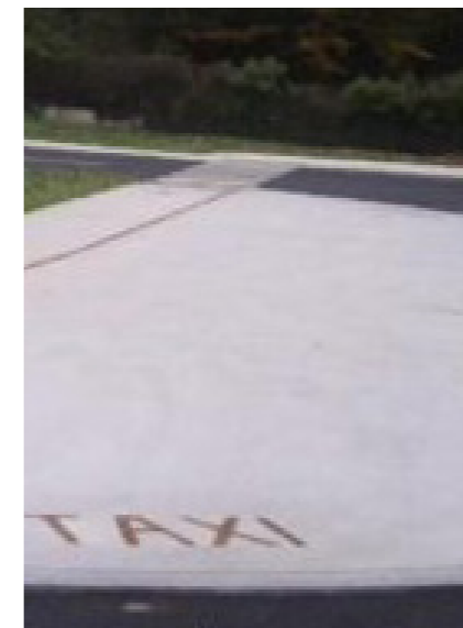
Signalétique 'Taxi' en fonte pour marquer les stationnements
