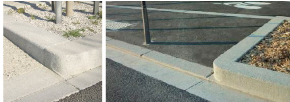
Bordures avec éléments spéciaux pour traitement qualitatif des îlots de voirie
