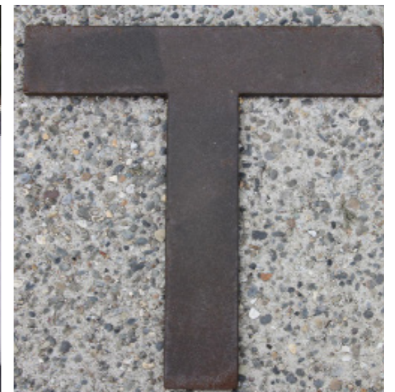
Clou de marquage en croix en fonte pour délimiter les stationnements réservés aux taxis
