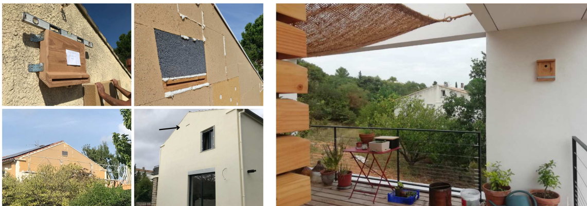
Gîte à chauve-souris intégré à l'isolation par l'extérieur, et nichoir © Association Cohab
