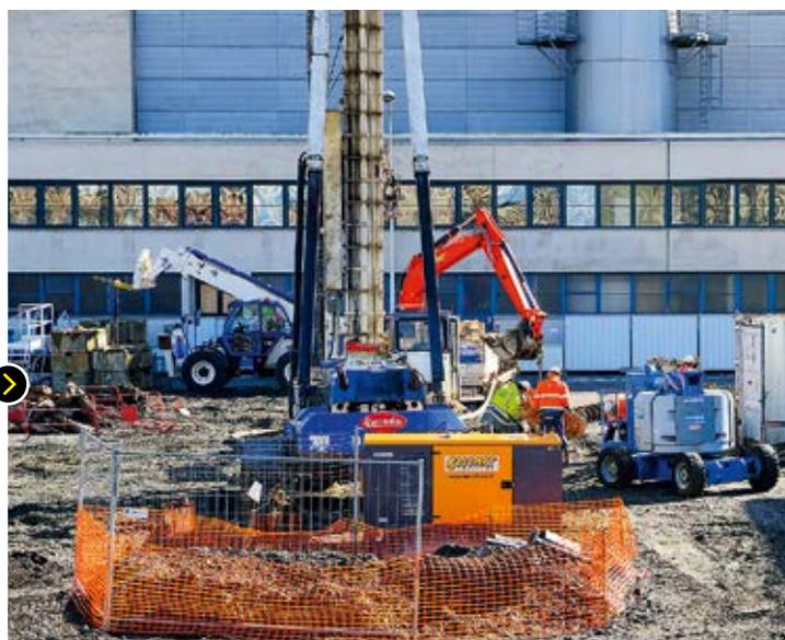
*Côté Édouard Vaillant, la fondation de la culée a été réalisée fin mars. Début avril, les fondations de la rampe hélicoïdale et de la rampe droite seront faites, suivies, fin avril de la construction de l'escalier sur la culée, côté Sanitas. Les 2 travées de la passerelle seront livrées fin mai-début juin et assemblées sur place, au sol, avant d'être posées par levage (de nuit) en septembre.*
