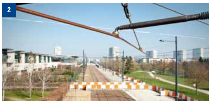
Photo 2 : la ligne aérienne de contact (alimentation électrique).
