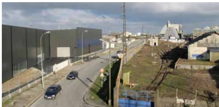
Socofer (à gauche) et Dalkia (à droite) s'installent sur le site du Magasin général
