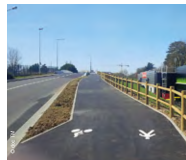
Aménagement du pont Maupas.
