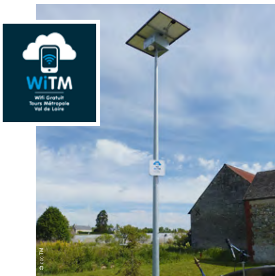
Borne wifi solaire à Saint-Genouph
