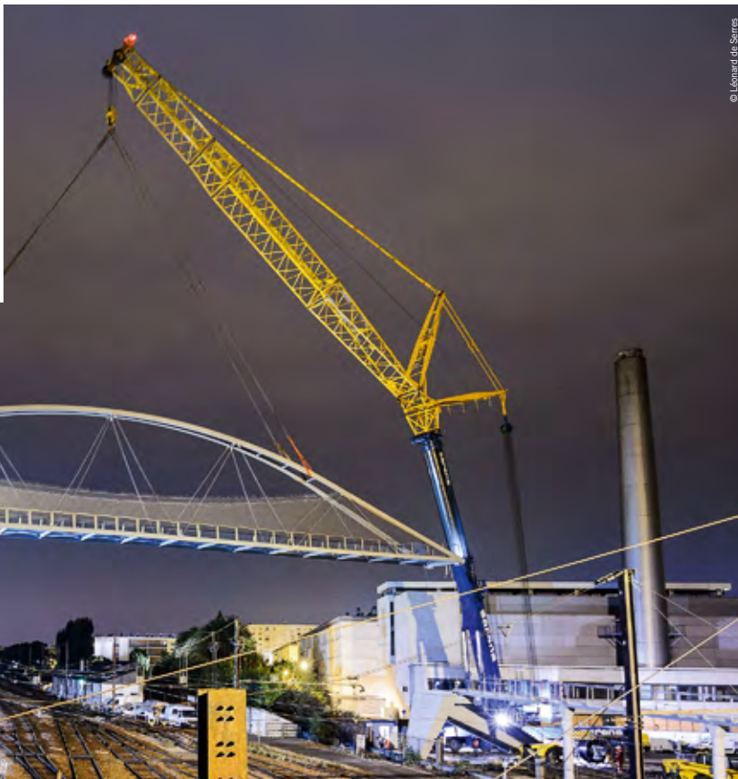
L'assemblage des 2 parties de la passerelle (bow-windows), de 54 m et 40 tonnes chacune, s'est déroulé en 2 nuits, les 14 et 19 septembre. Une opération soigneusement préparée par l'entreprise Viry qui dispose d'une grue de levage, unique en France, capable de soulever 700 tonnes.
