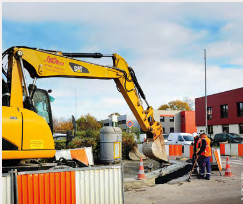
Réhabilitation du parc d'activités des Granges Galand.
