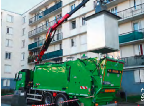
Enlèvement d'un conteneur enterré dans le quartier du Sanitas à Tours
