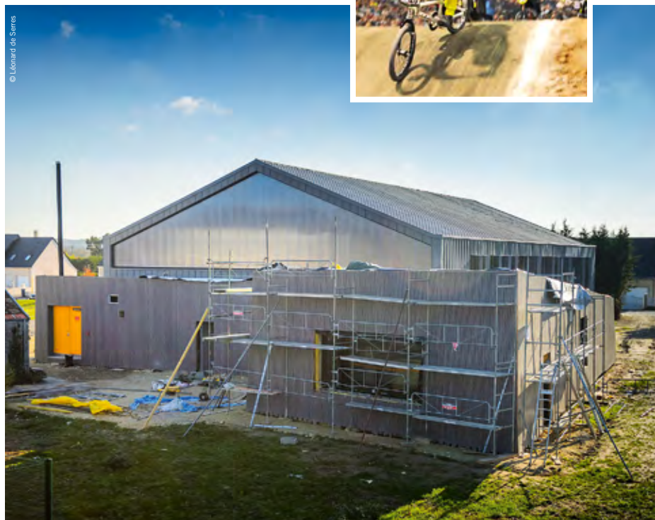
Rénovation et extension du gymnase de Berthenay.
